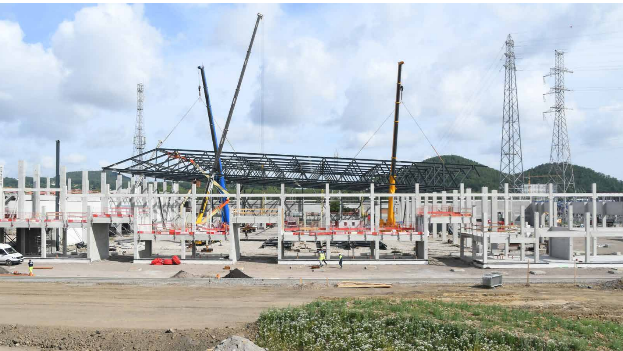
Construction d'une nouvelle halle des foires à Liège Architecte : Archipelago
