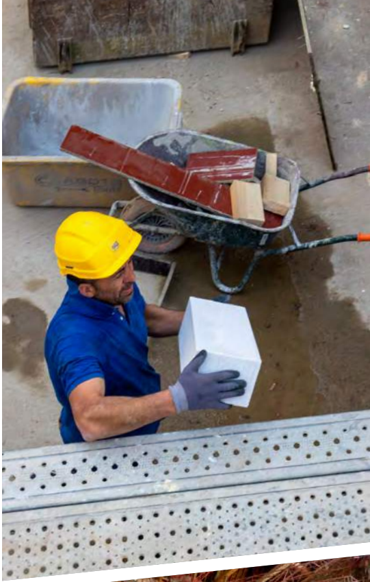
Renovation et extension du FIACRE à Liège pour la création d'un hub créatif Architecte : Valentiny Architectes SRL
