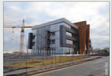
Construction d'un immeuble de bureaux pour Igretec à Gosselies
