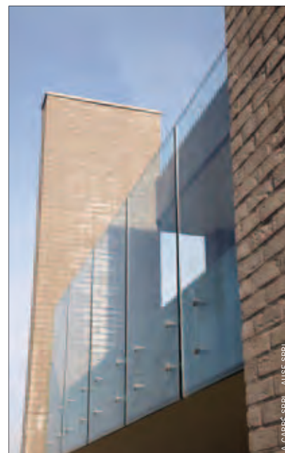
Construction de la résidence Clos des charmes à Beaufays
