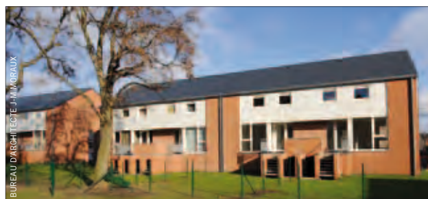
Construction de 30 logements à Montignies-sur-Sambre
