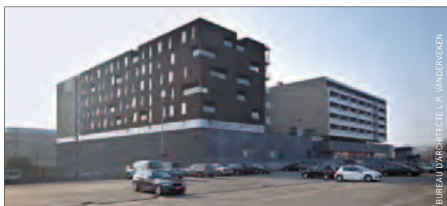
Construction d'un Etap Hotel et d'un centre commercial à Bruges
