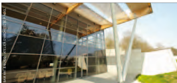
Construction du restaurant de l'Ulg au Sart-Tilman
