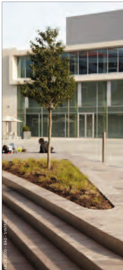
Construction des bureaux et studios de la RTBF à Liège
