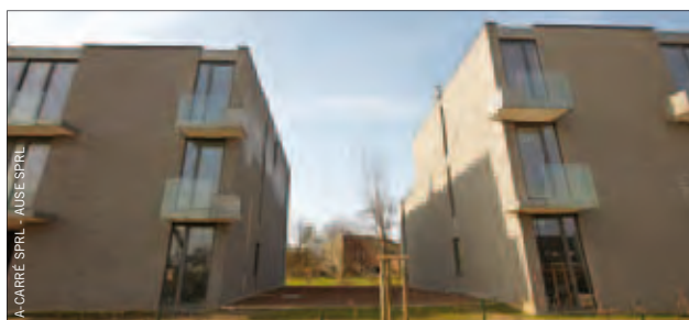
Construction de la résidence Clos des charmes à Beaufays
