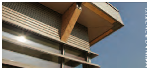
Construction du restaurant de l'Ulg au Sart-Tilman
