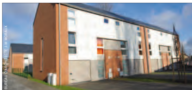
Construction de 30 logements à Montignies-sur-Sambre
