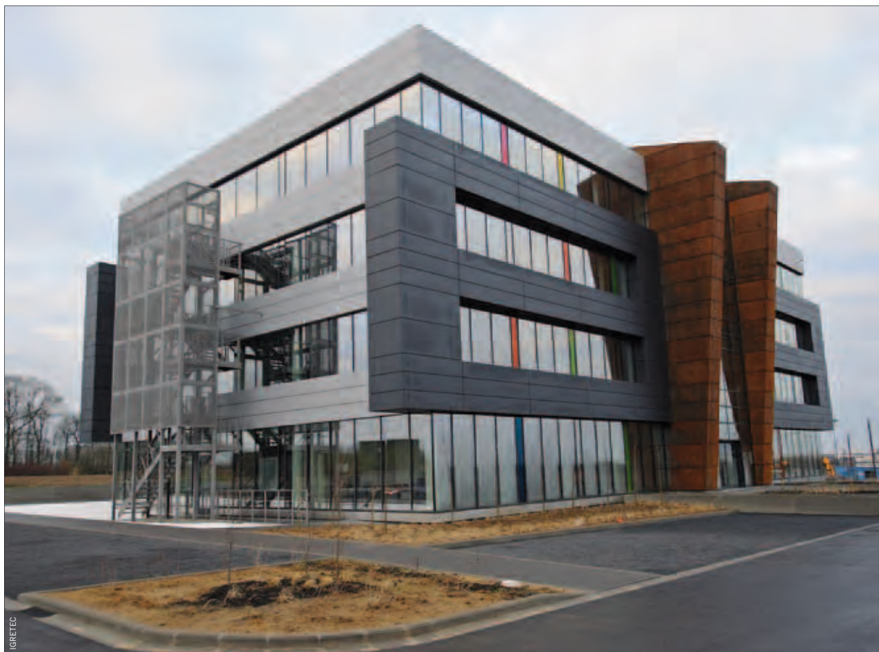
Construction d'un immeuble de bureaux pour Igretec à Gosselies
