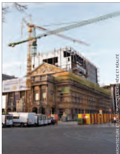
Rénovation de l'Opéra Royal de Wallonie à Liège
