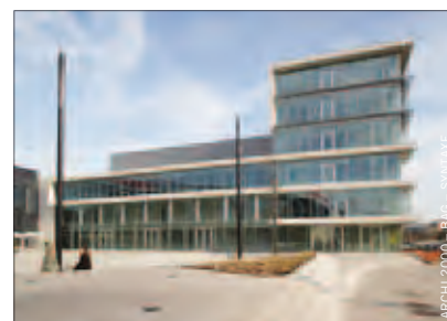
Construction des bureaux et studios de la RTBF à Liège
