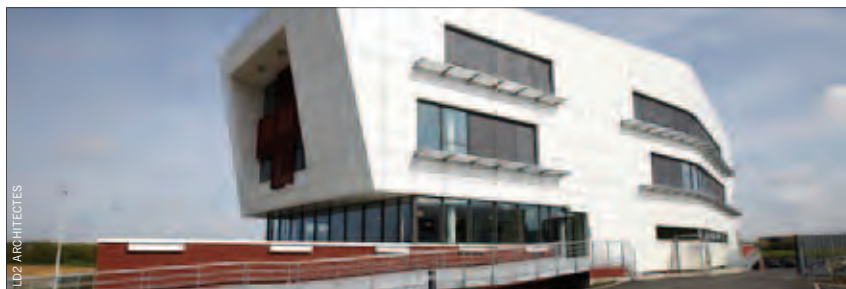
Construction des bureaux et laboratoires pour la Croix-Rouge à Rhisnes
