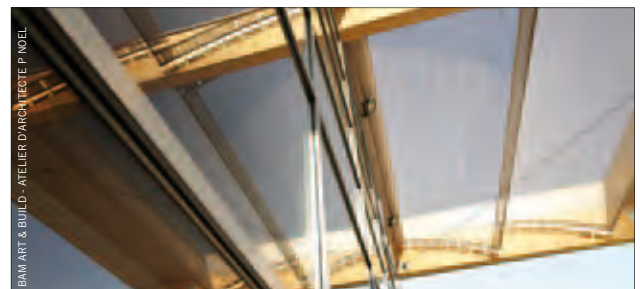
Construction du restaurant de l'Ulg au Sart-Tilman
