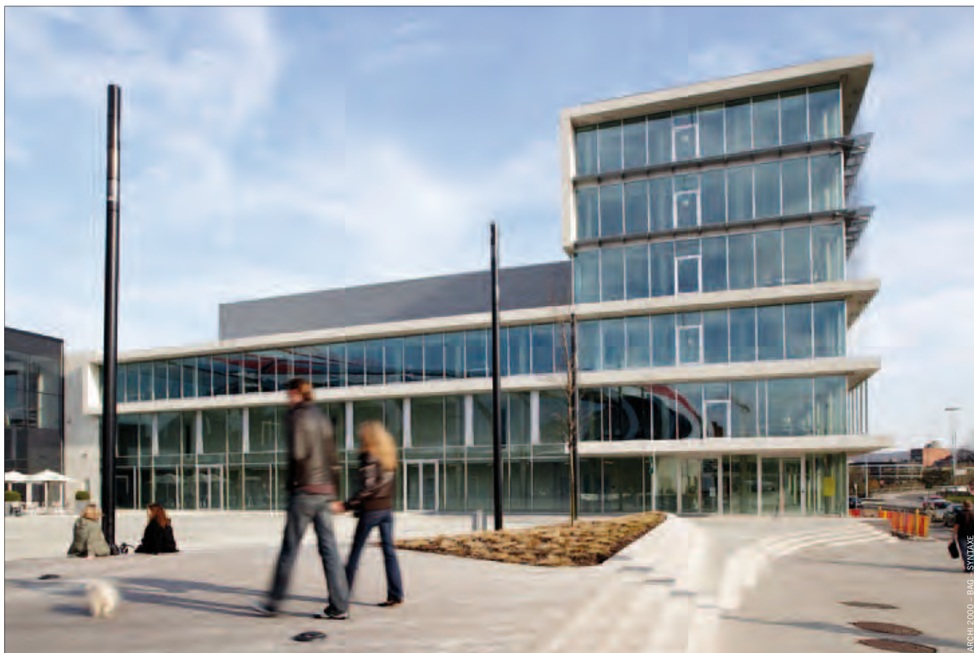
Construction des bureaux et studios de la RTBF à Liège
