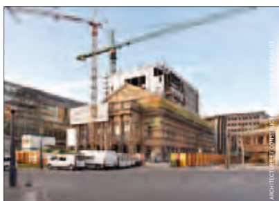
Rénovation de l'Opéra Royal de Wallonie à Liège
