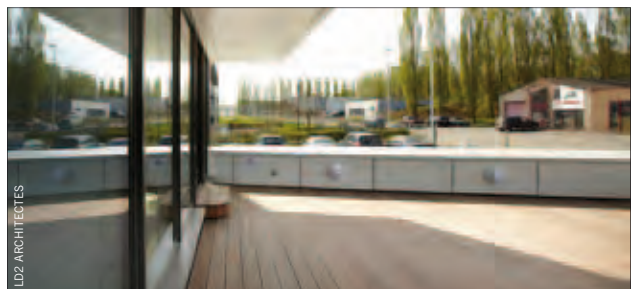
Construction des bureaux et laboratoires pour la Croix-Rouge à Rhisnes
