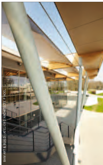
Construction du restaurant de l'Ulg au Sart-Tilman
