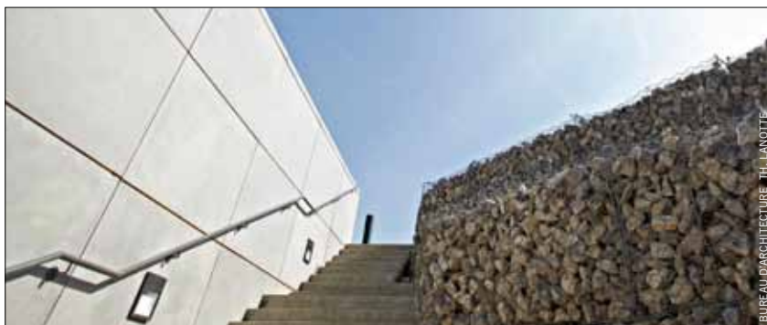
Construction d'un centre de formations et de colloques pour la CSC à Bouge.
