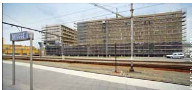
Construction du centre commercial « Groen Brugge » et d'un Etap Hotel à Bruges.
