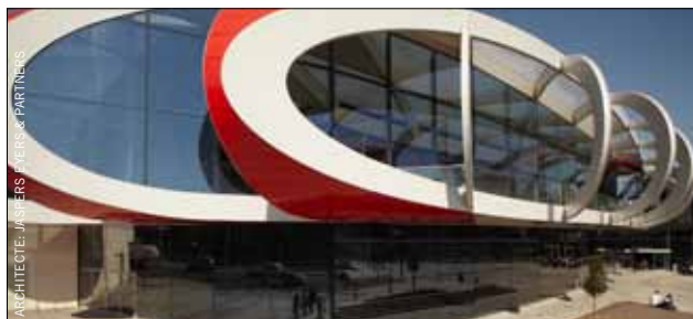
Construction du centre commercial La Médiacité à Liège.
