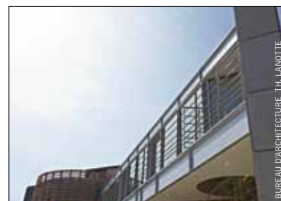
Construction d'un centre de formations et de colloques pour la CSC à Bouge.
