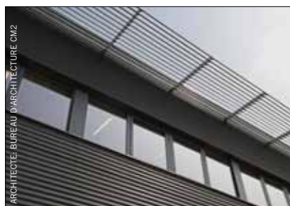
Construction d'un hall de stockage et de bureaux pour la SA Energys.
