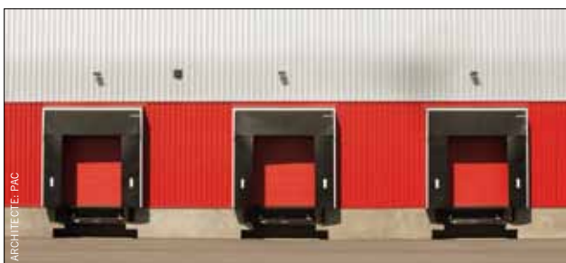
Construction d'un hall relais pour le port autonome de Charleroi.
