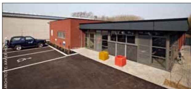
Construction d'un bâtiment administratif pour la ville de Tongres.
