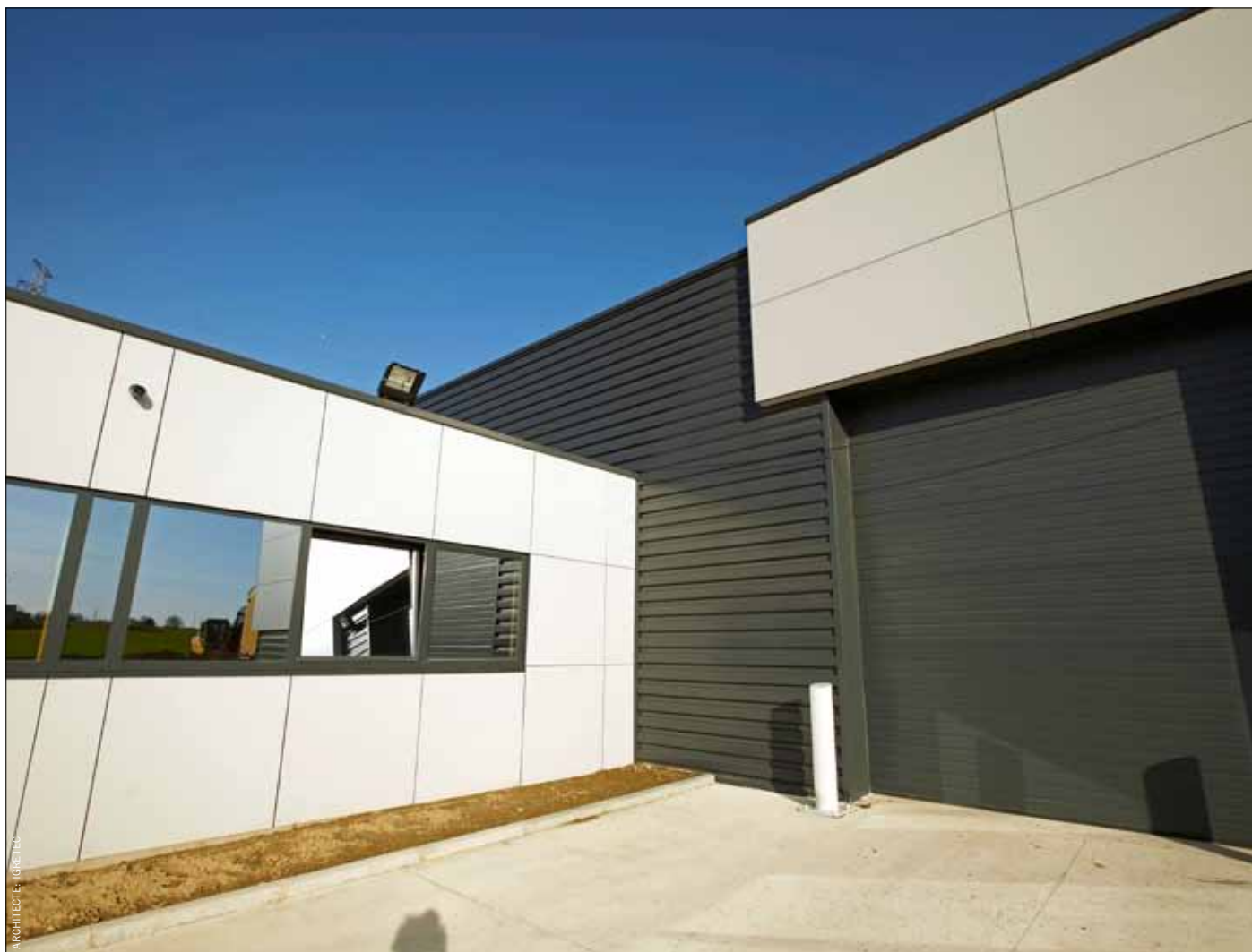
Construction d'un hall relais à Fleurus pour Igretec.
