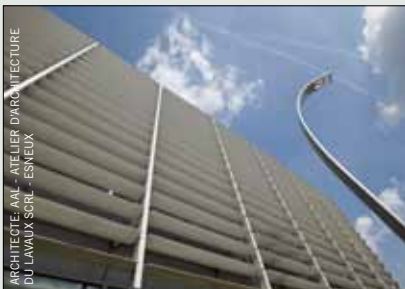
Construction d'une usine et de bureaux pour la SA Schreder
