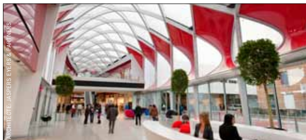
Construction du centre commercial La Médiacité à Liège.
