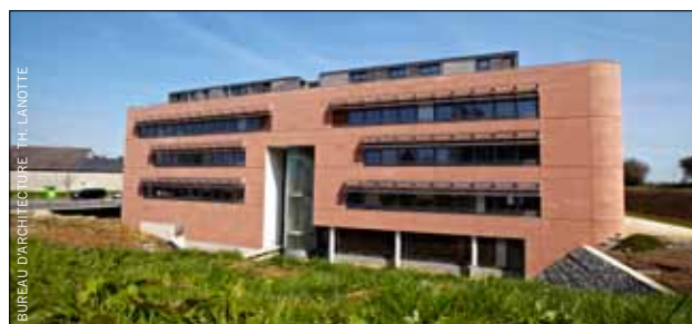
Construction d'un centre de formations et de colloques pour la CSC à Bouge.
