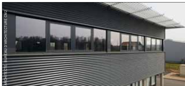
Construction d'un hall de stockage et de bureaux pour la SA Energys.
