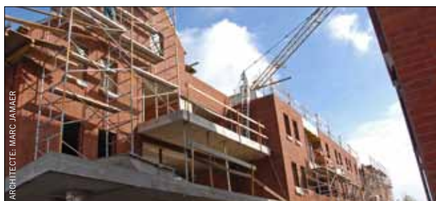
Construction d'un complexe bibliothèque et appartements à Kortesseem.
