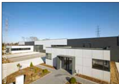
Construction d'un hall relais à Fleurus pour Igretec.
