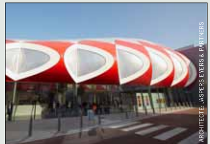
Construction du centre commercial La Médiacité à Liège.
