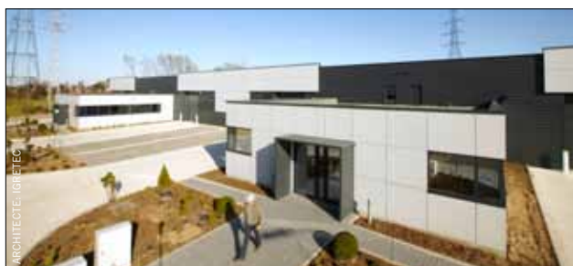
Construction d'un hall relais à Fleurus pour Igretec.
