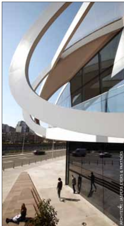
Construction du centre commercial La Médiacité à Liège.
