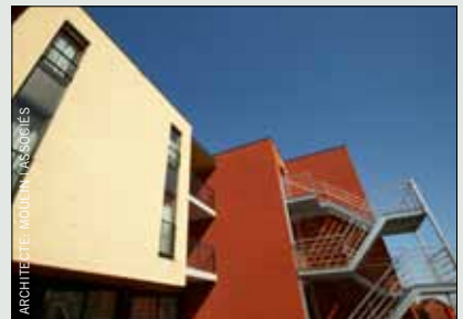
Construction d'un immeuble de résidences services pour le CPAS de Charleroi.
