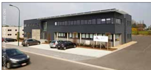
Construction d'un hall de stockage et de bureaux pour la SA Energys.
