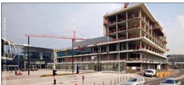
Construction des bâtiments de la RTBF à Liège.
