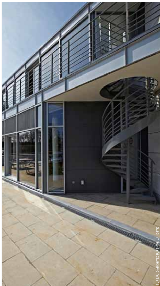
Construction d'un centre de formations et de colloques pour la CSC à Bouge.
