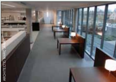
Construction d'un complexe bibliothèque et appartements à Kortesseem.
