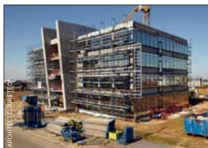
Construction d'un immeuble de bureaux «Agoria» pour Igretec
