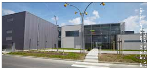
Construction d'une usine et de bureaux pour la SA Schreder.
