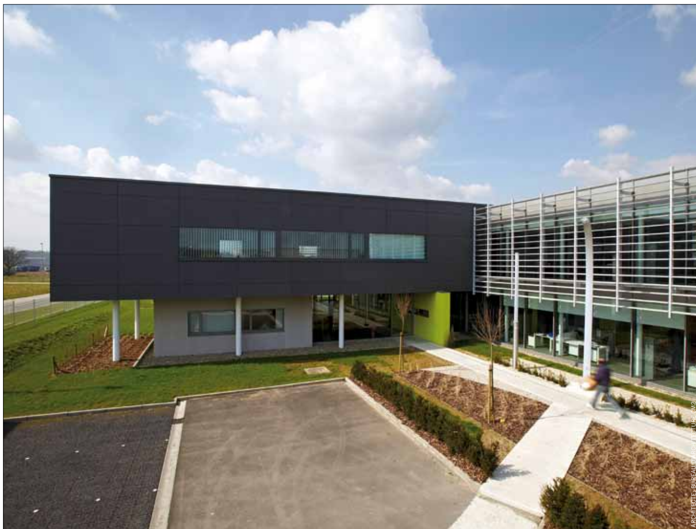
Construction d'un hall de stockage et de bureaux pour la SA Schreder.
