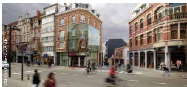
Rénovation d'un magasin et d'appartements à Louvain.
