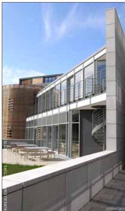
Construction d'un centre de formations et de colloques pour la CSC à Bouge.
