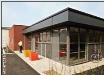
Construction d'un bâtiment administratif pour la ville de Tongres.
