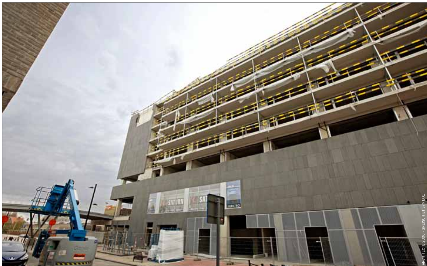
Construction des bâtiments de la RTBF à Liège.
