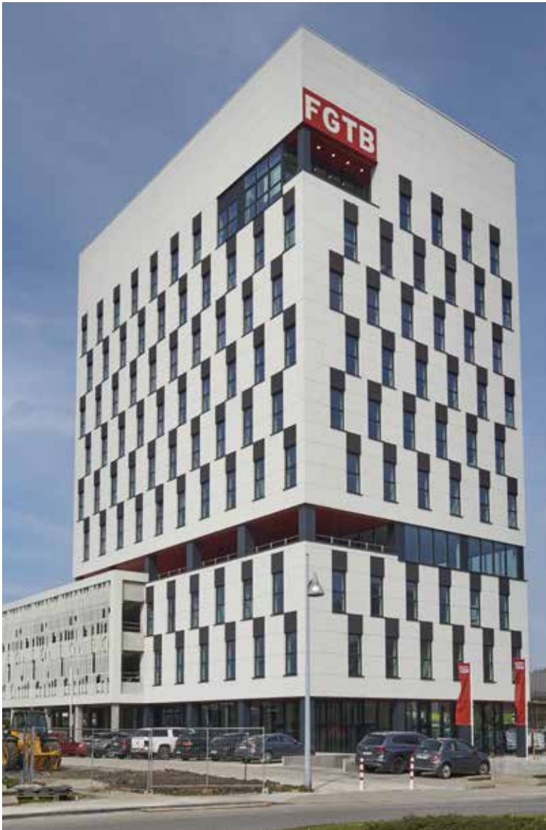
Construction du nouveau Centre Sportif « La Marlette » à Seneffe LPP Architectes
