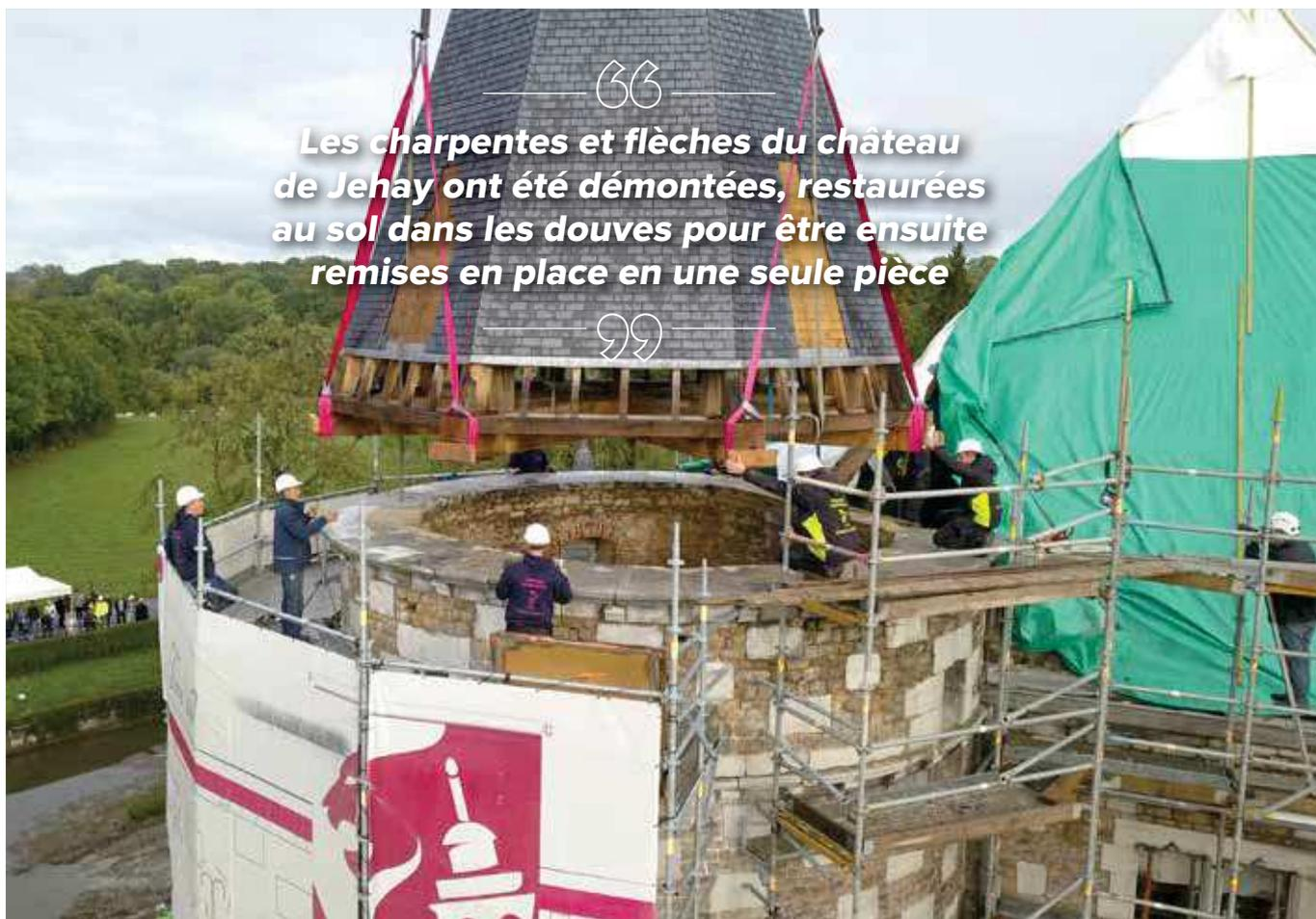
Les charpentes et flèches du château de Jehay ont été démontées, restaurées au sol dans les doutes pour être ensuite remises en place en une seule pièce
