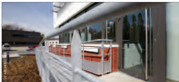
Construction des bureaux et laboratoires pour la Croix-Rouge à Rhisnes
