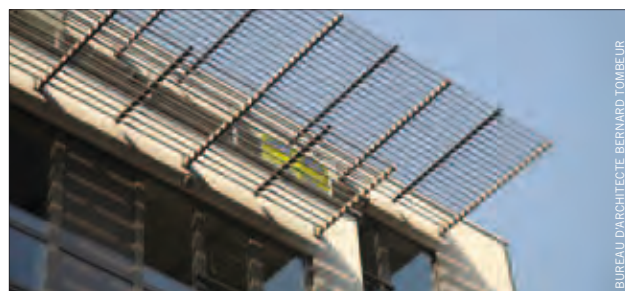
Construction de la résidence Eugène Ysaye - Place Saint-Jacques à Liège
