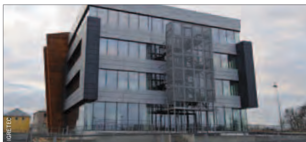
Construction d'un immeuble de bureaux pour Igretec à Gosselies
