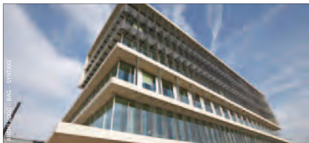
Construction des bureaux et studios de la RTBF à Liège
