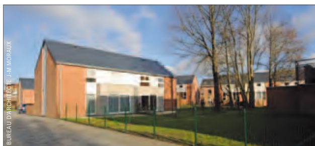
Construction de 30 logements à Montignies-sur-Sambre
