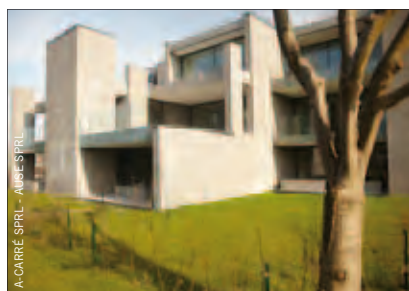
Construction de la résidence Clos des charmes à Beaufays
