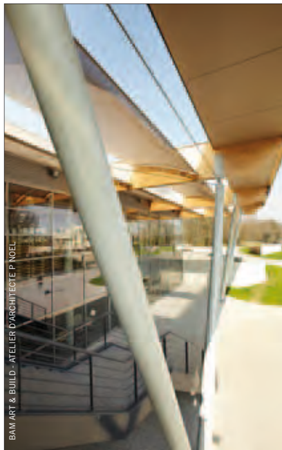
Construction du restaurant de l'Ulg au Sart-Tilman
